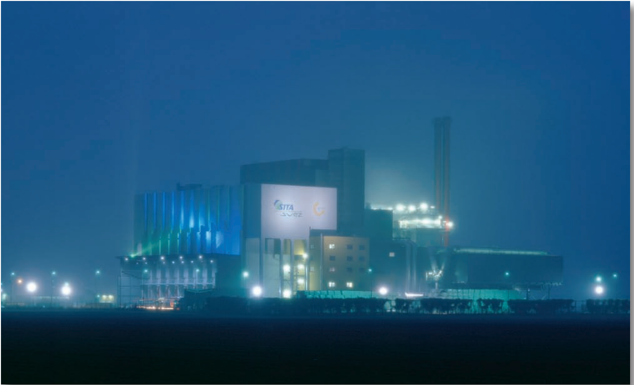
Feuerlöschanlagen SITA Abfallverwertung, Zorbau
